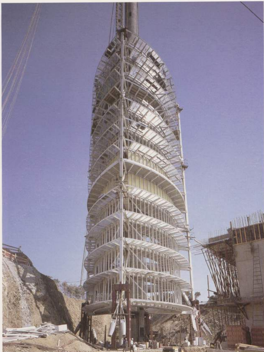
Construcción en tierra de las plataformas metálicas.
