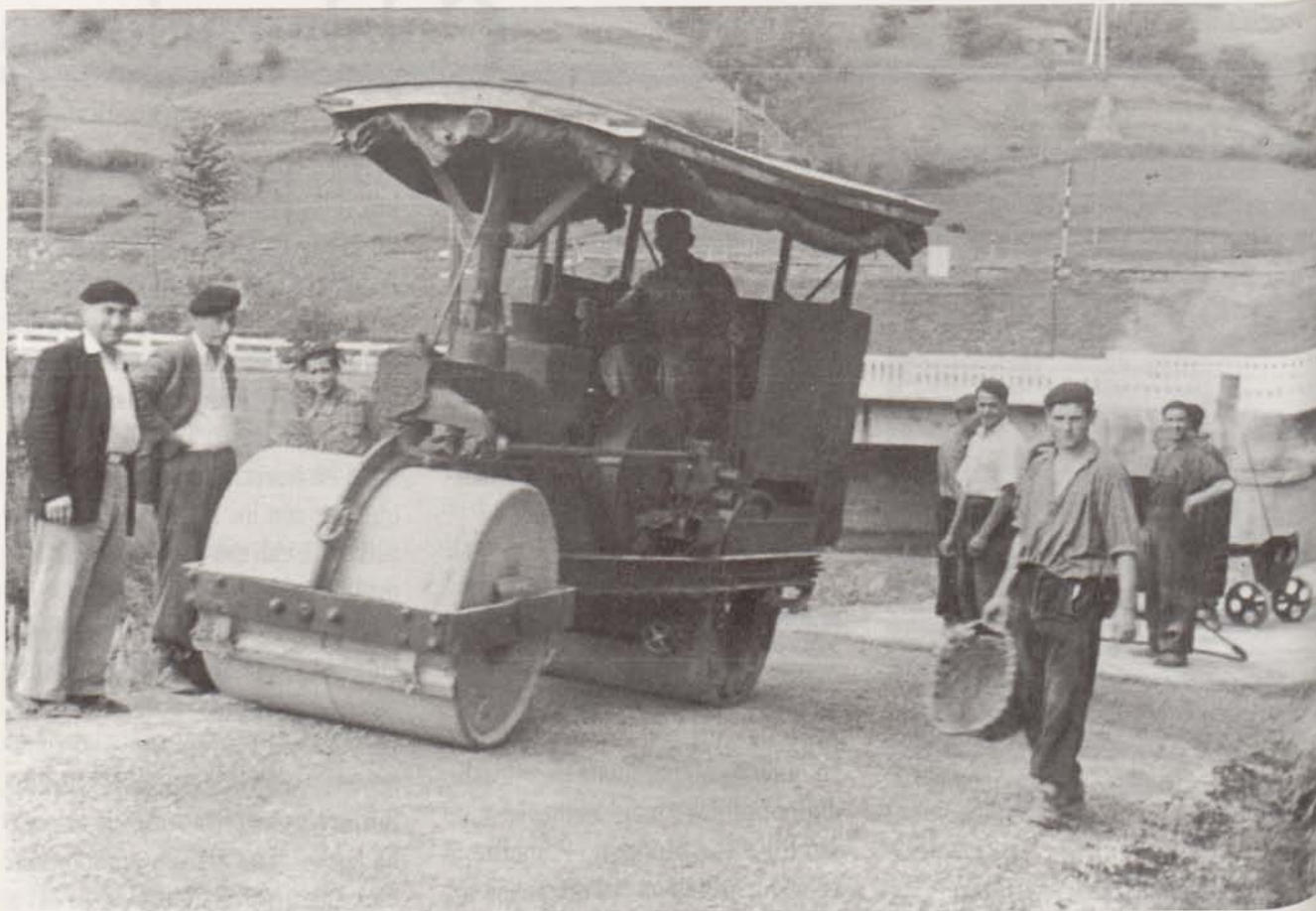
Brigada de camineros realizan trabajos de reparación en setiembre de 1954.
