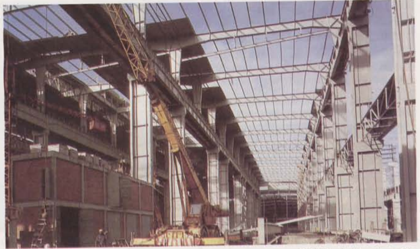
División de Construcción.
