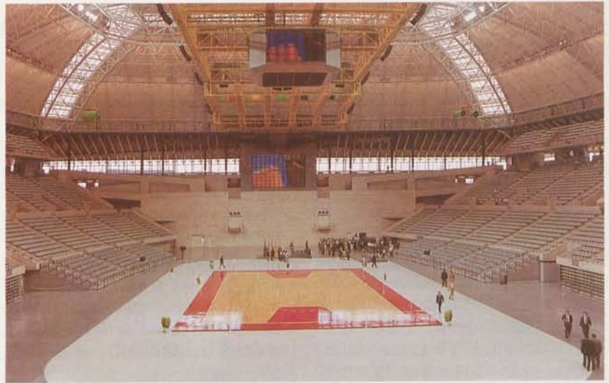
Vista general del Palau S. Jordi.
