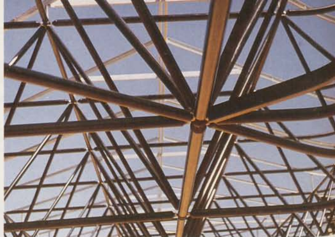
Detalle de la estructura espacial del Pabellón General de Sevilla
