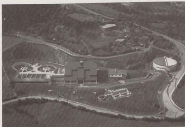
Vista general de la planta Potabilizadora de Cruces
