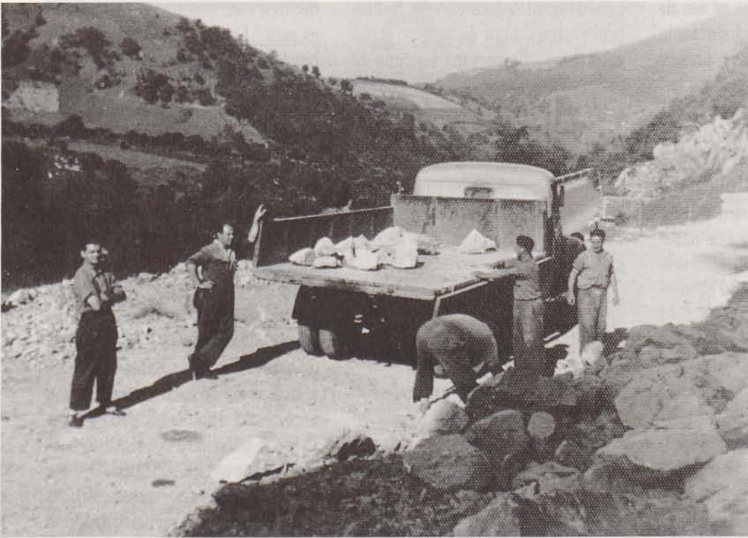
Camineros extrayendo piedra para la reparación de una carretera en los primeros años cincuenta.
