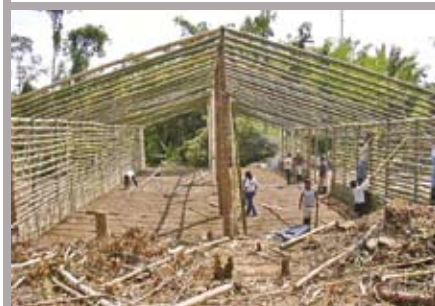
El esqueleto de una nave para gallinas (Ecuador).
