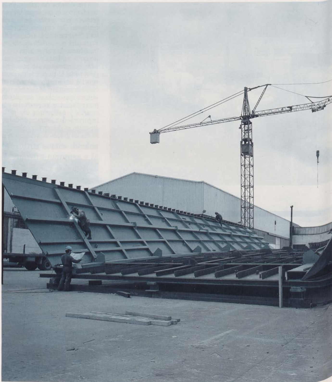
Estructura realizada por URSSA, S. COOP. en Valencia.
