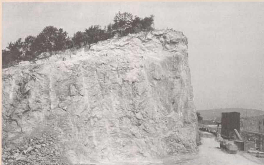
La cantera ROFER en Alza (San Sebastián) antes de la voladura el 9 de julio de 1993. Obsérvese su dimensión comparando con los trabajadores que aparecen en la parte superior. (Foto cedida por Manuel Gutierrez).
