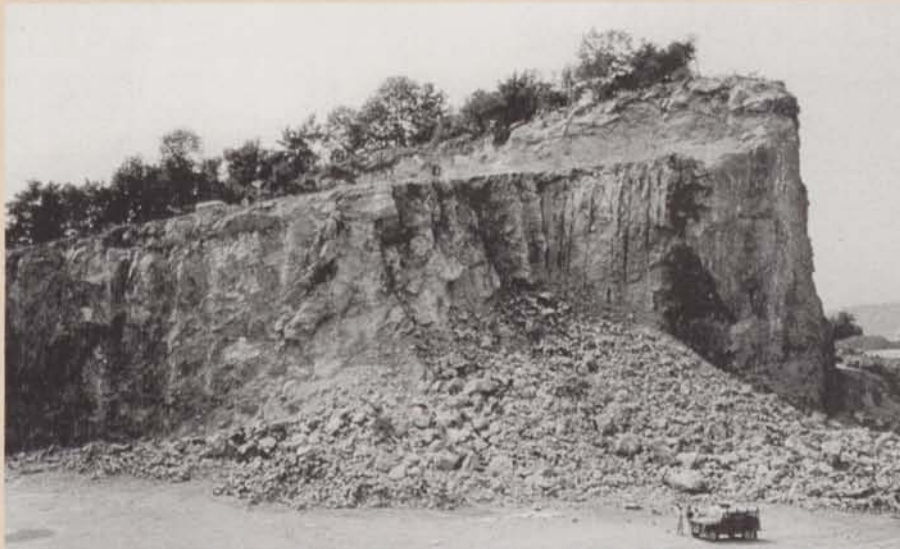
La cantera ROFER después de la voladura el 9 de julio de 1993. En la planta se acumulan las piedras segregadas. (Foto cedida por Manuel Gutierrez).
