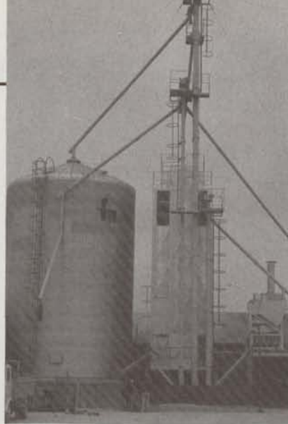
Instalación de almacenamiento y secado de maíz de Funcor
