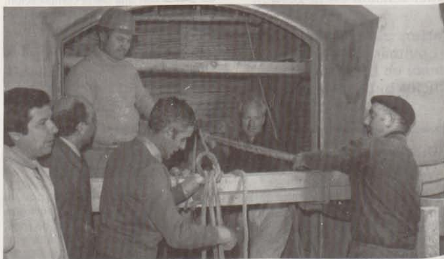
Colocación de la piedra por los trabajadores de Covimar en CLP de El Arenal
