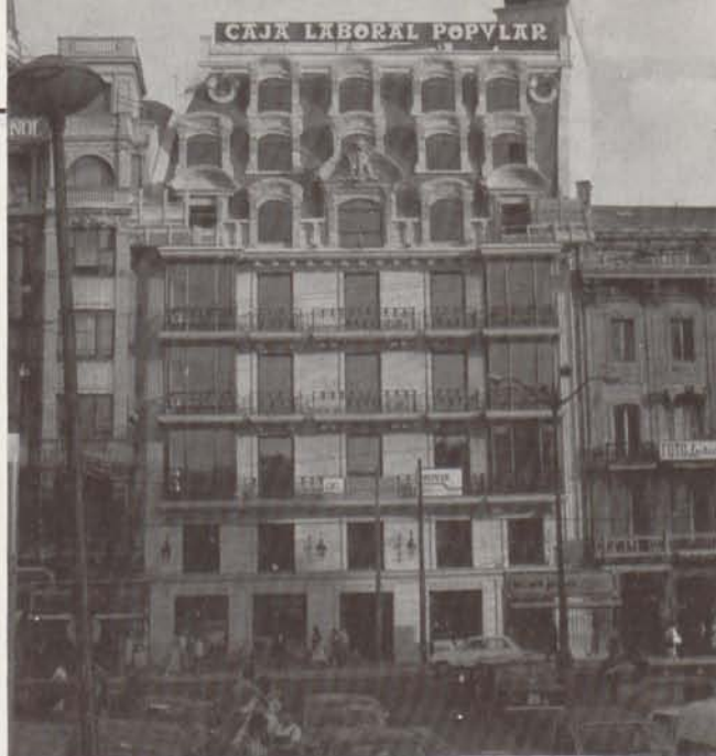
Exterior del edificio de Caja Laboral Popular en El Arenal bilbaino de Covimar
