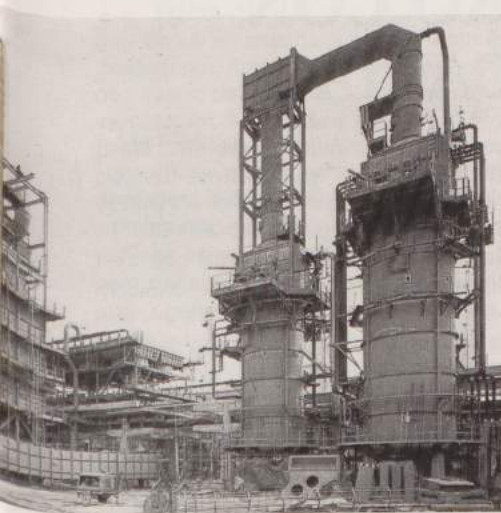
Estructura realizada por URSSA en la refinería de Petronor
