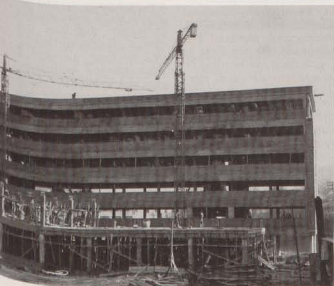
El actual edificio de Eskola en construcción
